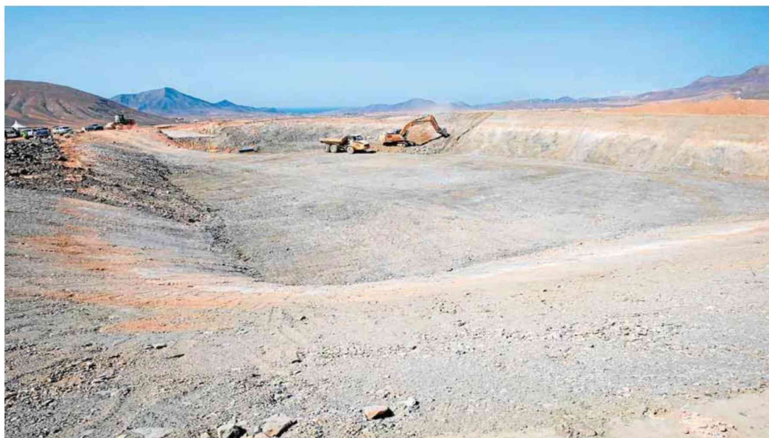
Presa de regulación en Tesejerague de la obra de modernización de regadíos en los municipios de Tuineje y Pájara. JAVIER MELIÁN / ACPI PRESS
