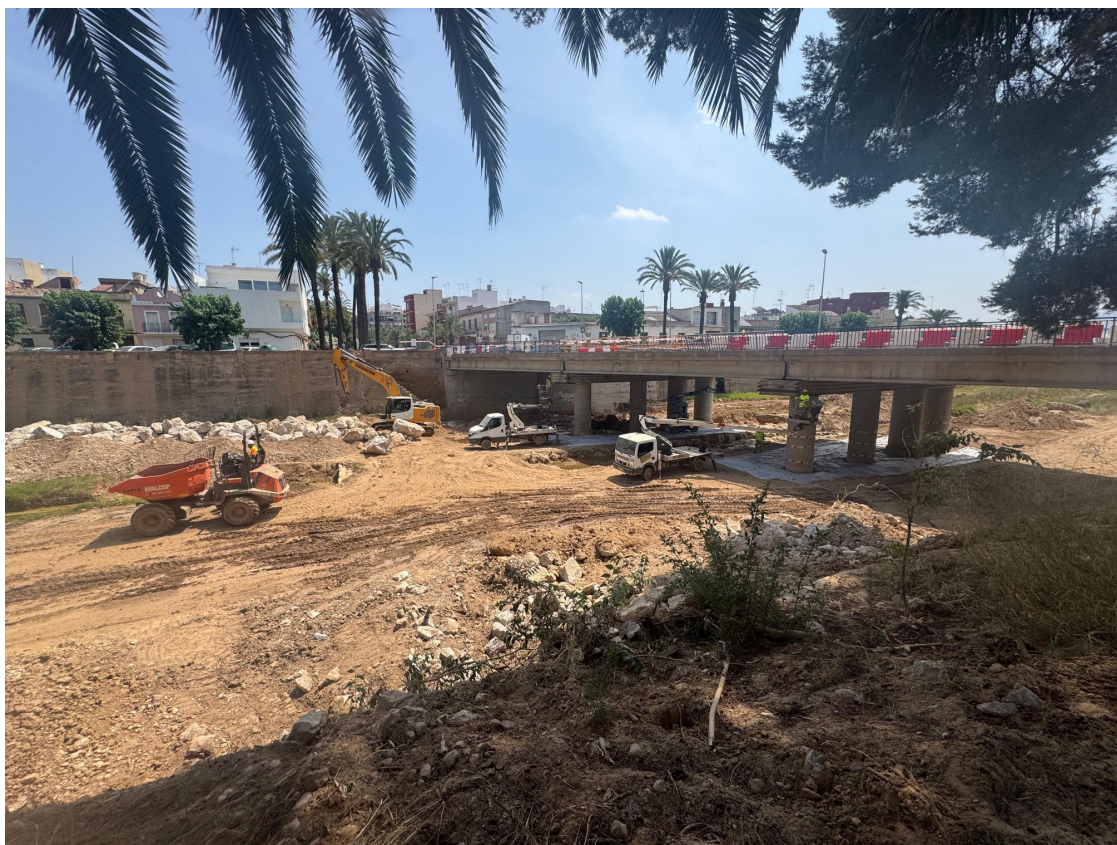
La Generalitat finalizará este verano la reparación de las infraestructuras locales de Algemesi afectadas por la dana
