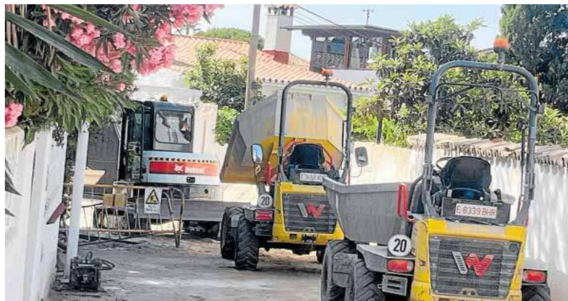
Los trabajos de saneamiento en la urbanización de Costabella han entrado en su fase final. JOSELE
